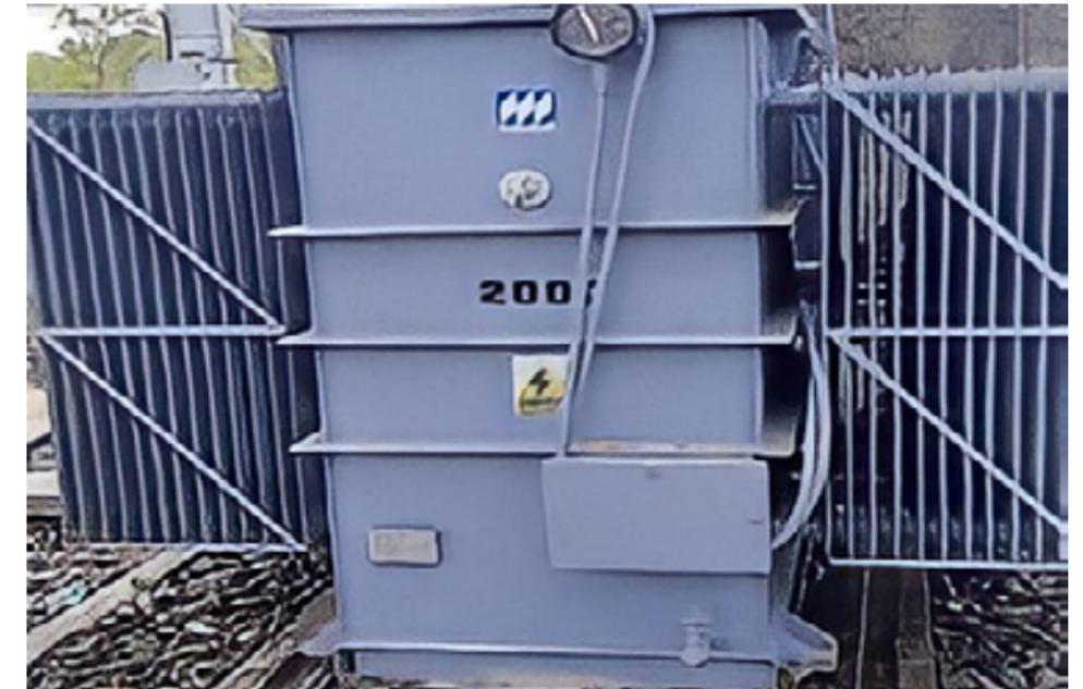
Traslado de transformador Trifásico de 2MVA (34.5 KV / 13.2 KV) Subestación San Miguel
