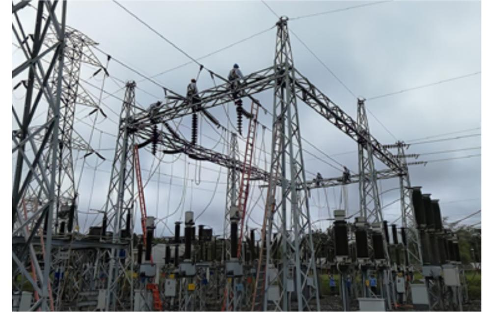
Reposición de la Barra principal de la subestación Certeguí – Nivel de tensión IV (115 KV)
