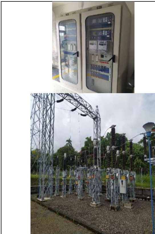
Sistema de medida tipo exterior, medidores en gabinete.
