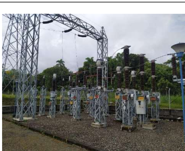
Sistema de medida tipo exterior, medidores en gabinete.
