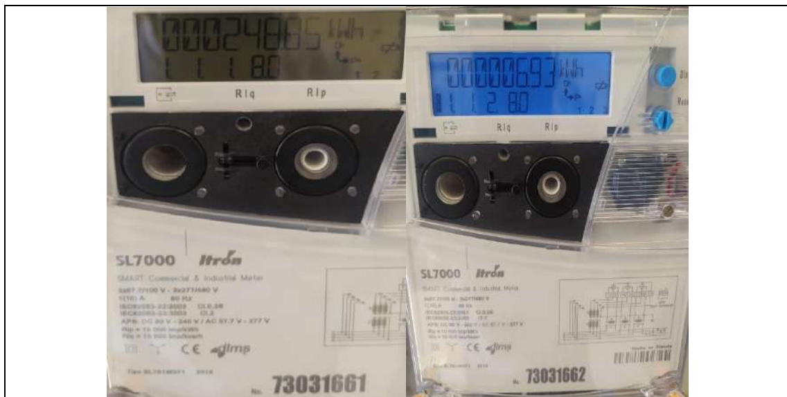
Resolución del medidor principal y respaldo en Kwh y Kvarh – Resolución en el perfil de carga 0,001 Kwh.
