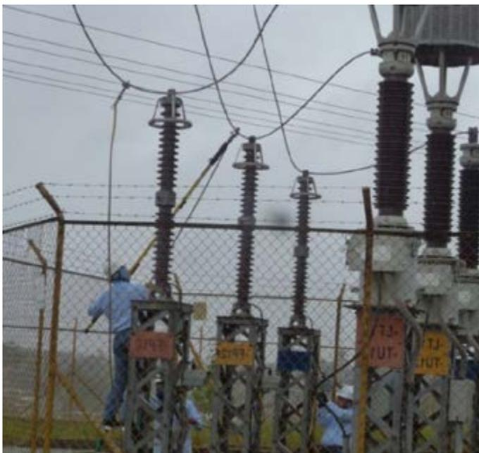
Reposición de pararrayos 115 KV en la bahía de línea Cértegui de la subestación Huapango.
