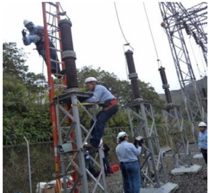
Reposición de pararrayos 115 KV en la bahía de línea Huapango de la subestación El Siete.
